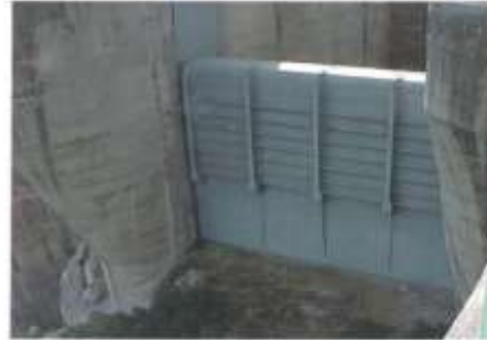
Paratoia dello scarico di superficie vista da monte
