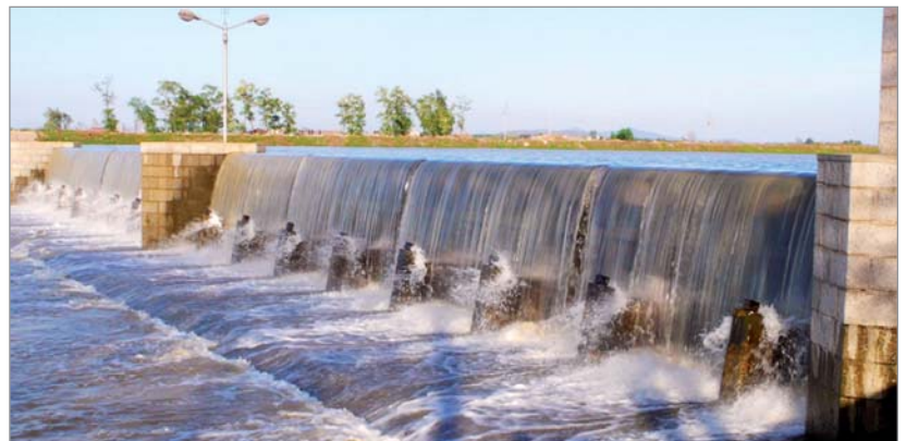
Abb. 2: Speicherungskaskade zur Grundwasseranreicherung (Foto: Dr. Luo, DHI-WASY GmbH)
