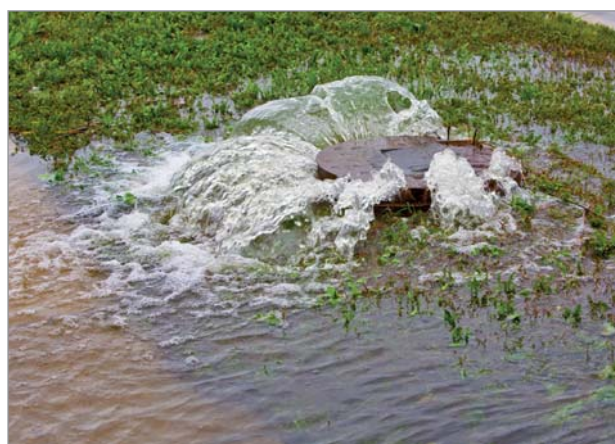
Abb. 5 (unten): Wasser dringt aus dem Kanalnetz an die Oberfläche (Foto: iStockphoto/Allkindza)
