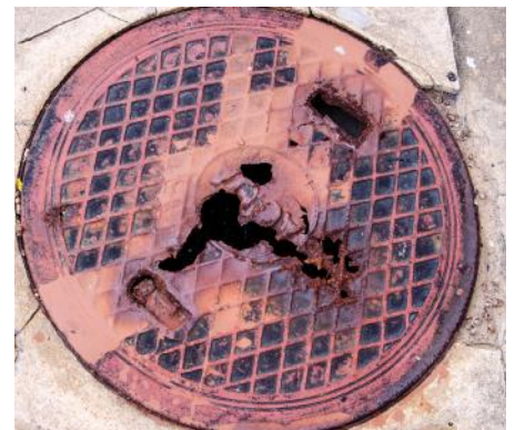
Korrodiertes Kanaldeckel
