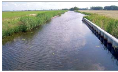
Abb. 3: Erscheinungsbild der Karthane im Unterlauf – stark begradigt und reguliert. (Foto: Mike Ramelow, 4.7.2012)
