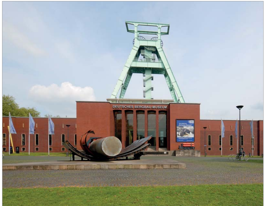
Abb. 2: Bergbau-Museum Bochum mit Baustelle Schwarzer Diamant (Foto: Jochen Jansen, http://de.wikipedia.org )
