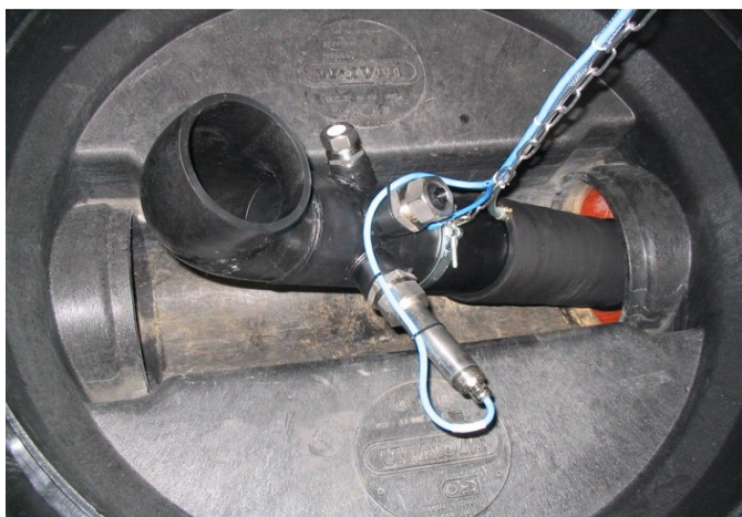
Aplikace Nivus Pipe Profileru © DHI / Foto: www.nivus.com
