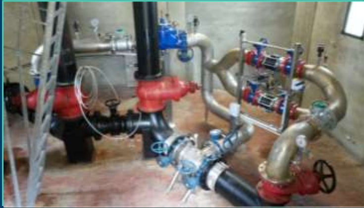
Gruppo di riduzione e misura di Correggio Pensile
