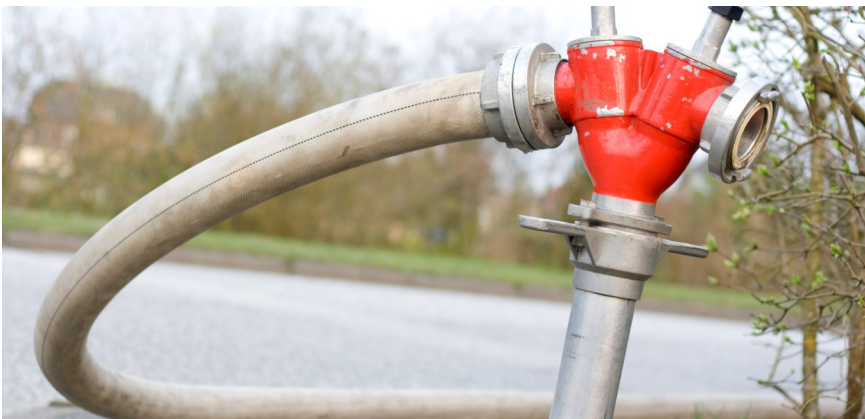
Die Löschwasserversorgung löst in vielen Netzen die stärkste hydraulische Belastung aus.
