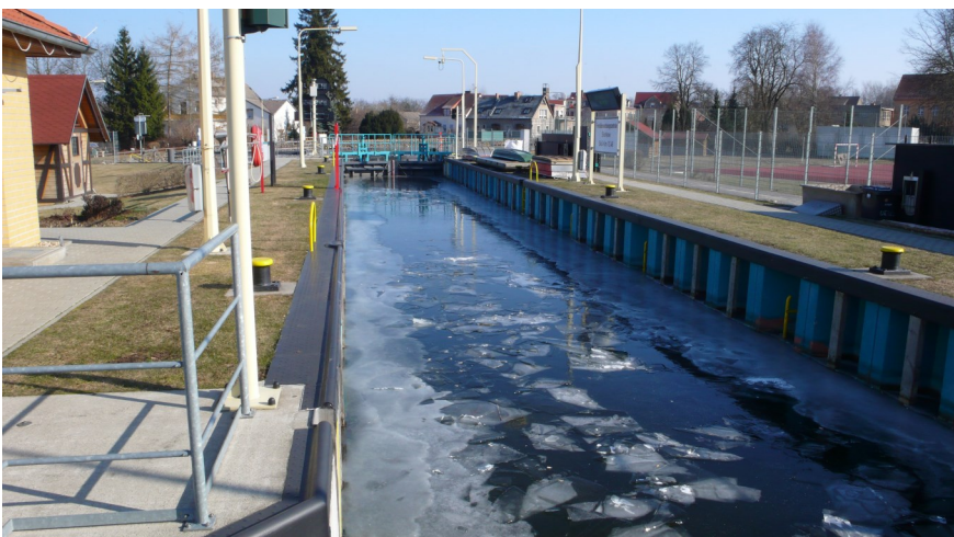
Schleusenammer des Ersatzneubaus ©DHI
