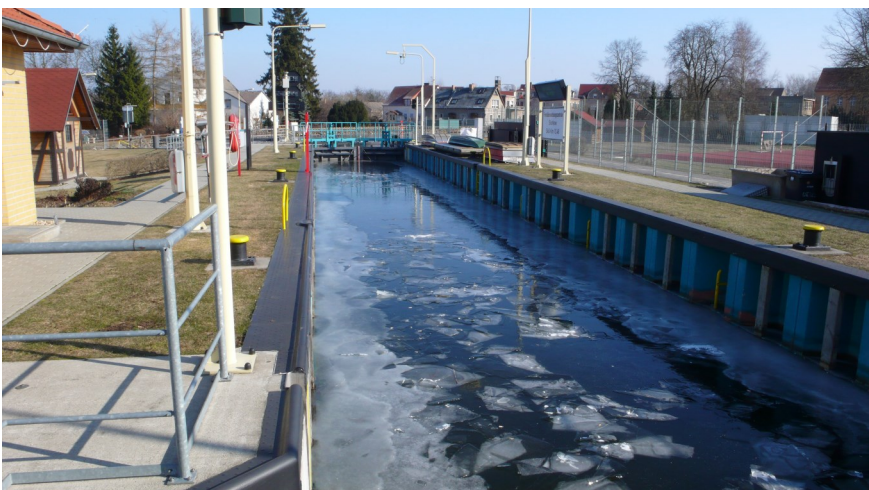
Schleusenammer des Ersatzneubaus ©DHI
